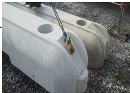
②吊り金具取付状況
