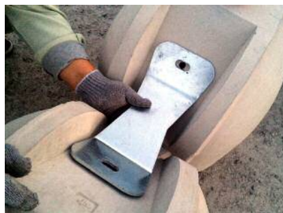
②プレート穴確認
