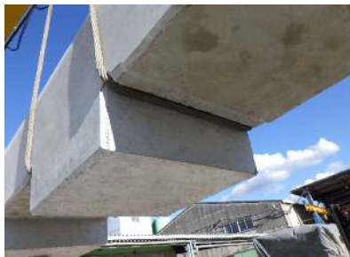
①吊上状況
