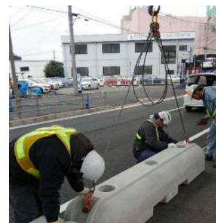
③吊上状況
